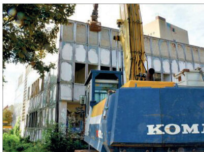
Der Mittelbau mit Mensa und Veranstaltungssaal wird in den kommenden Monaten abgerissen. Hier soll ein Stadtplatz entstehen. Fotos (2): Harter
