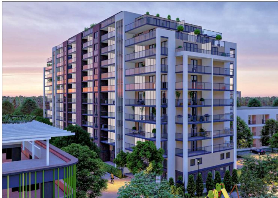
Nach den Plänen von Riklef Roehl soll der Zehngeschosser der ehemaligen SED-Parteischule „Hermann Matern“ – Dauerschandfleck an der Klosterwuhne – nach der Sanierung nicht mehr wiederzuerkennen sein.
