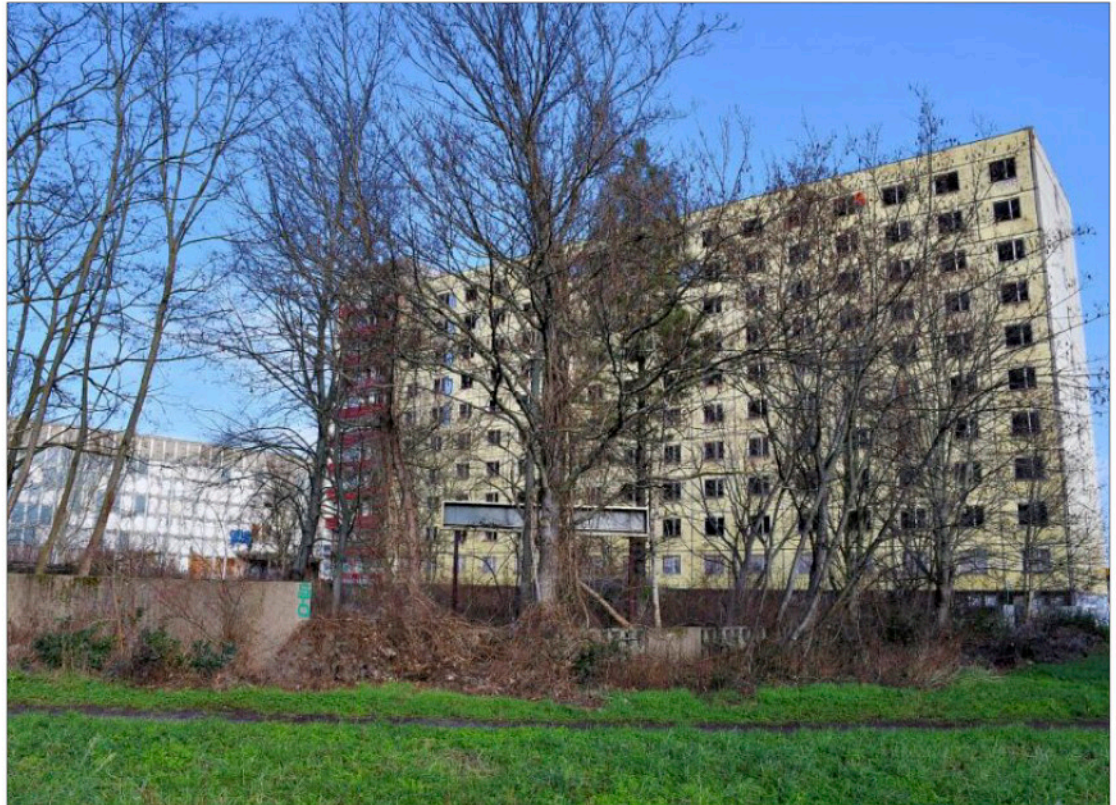
In der kommenden Woche beginnen auf dem Gelände der ehemaligen Parteischule an der Klosterwuhne umfangreiche Rodungsarbeiten. Der gesamte Wildwuchs soll entfernt werden, schützenswerte Bäume bleiben stehen.
